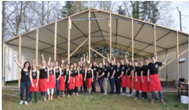
Abbildung 1: Mitglieder des OYS beim Baustart im April 2016
